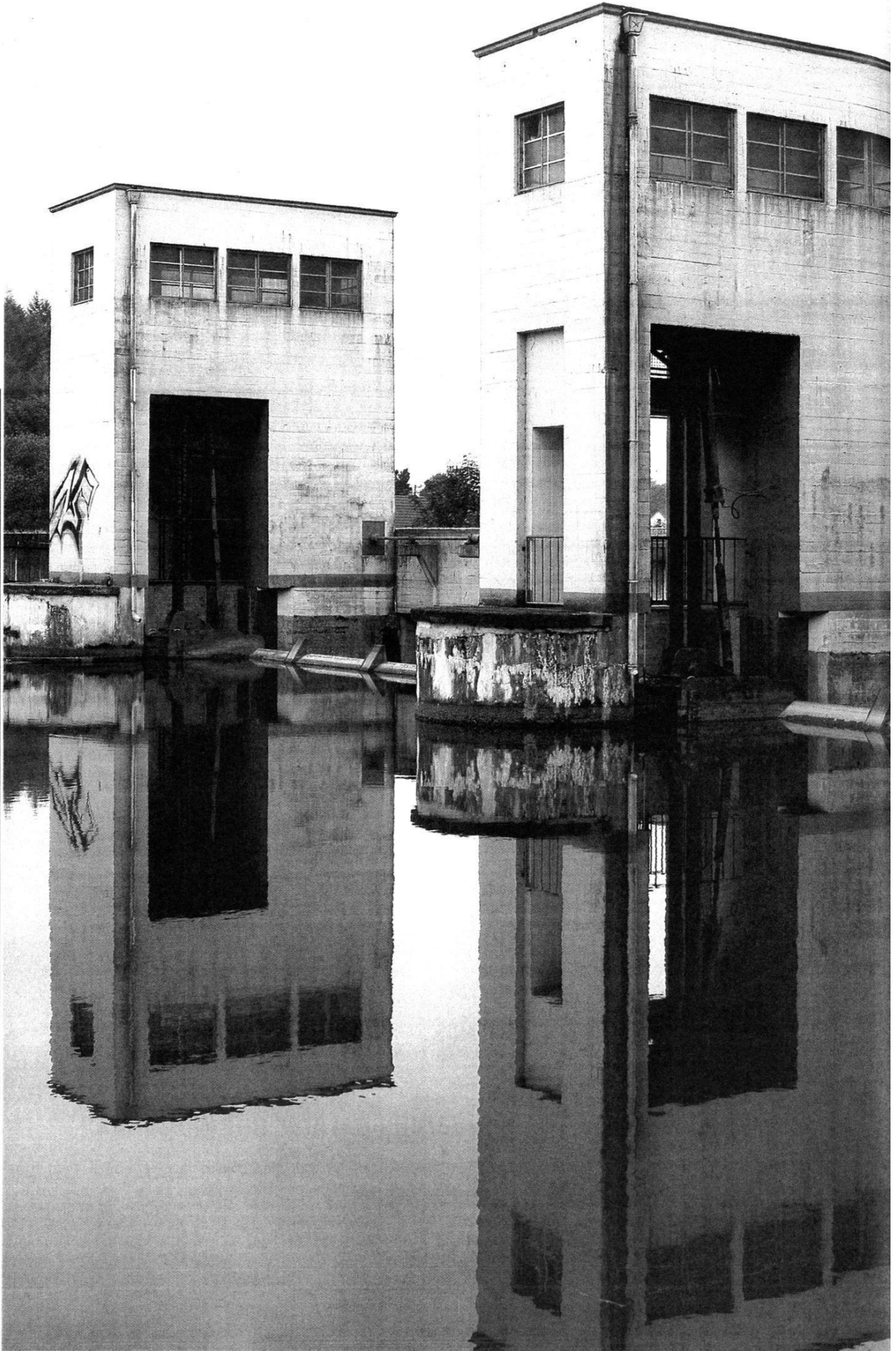
Am Wehr: in Ehreshofen wird das Wasser für ein 1.100-kW-Kraftwerk gestaut.
